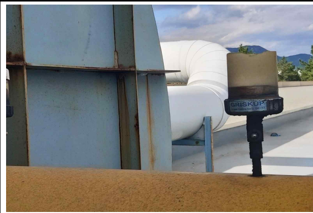
Fan Bearing Oil 주입기 파손 : 비정상 운전
